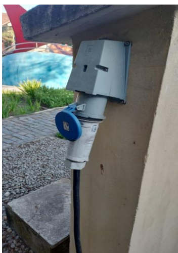
Foto: conexão do cabo elétrico do caminhão com a rede elétrica local.
