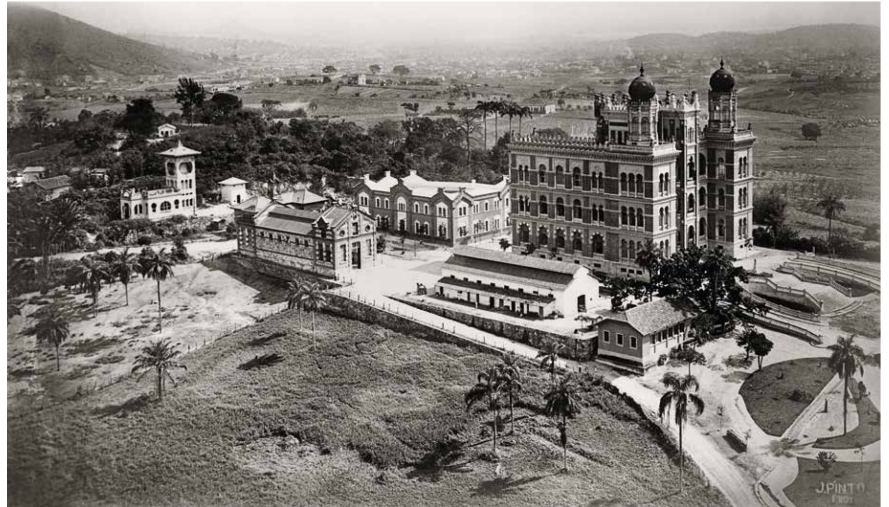
Conjunto arquitectónico de Manguinhos, en la década de 1930. Algunas edificaciones, como la antigua Caballeriza al lado del Castillo y el acuario (edificio a la izquierda), fueron demolidos.
